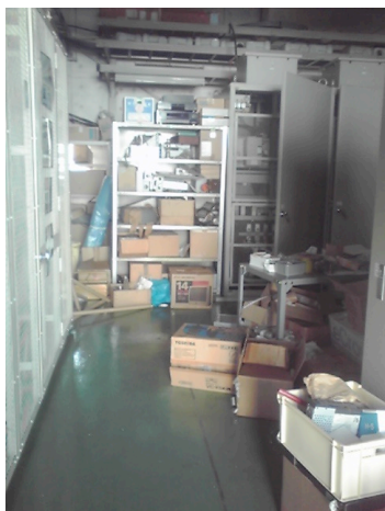
左入口から。左手は変電設備。棚、空調。軽量物散乱。FXキッカー電源ラック数台ずれる。
