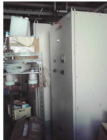
AVR3 が移動。背面ケーブルラックも引っ張られている。
