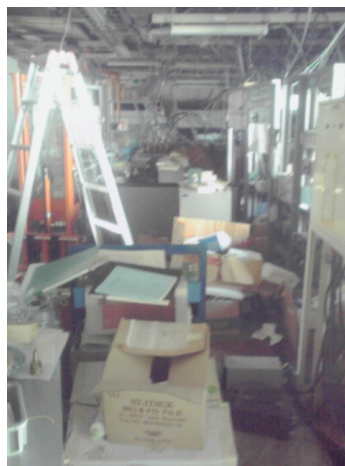
左入口から。左手は変電設備。棚、空調。軽量物散乱。FXキッカー電源ラック数台ずれる。
